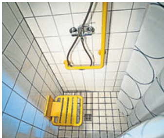
Duschtsitz in einer barrierefreien Wohnung. Foto: Ole Spata
