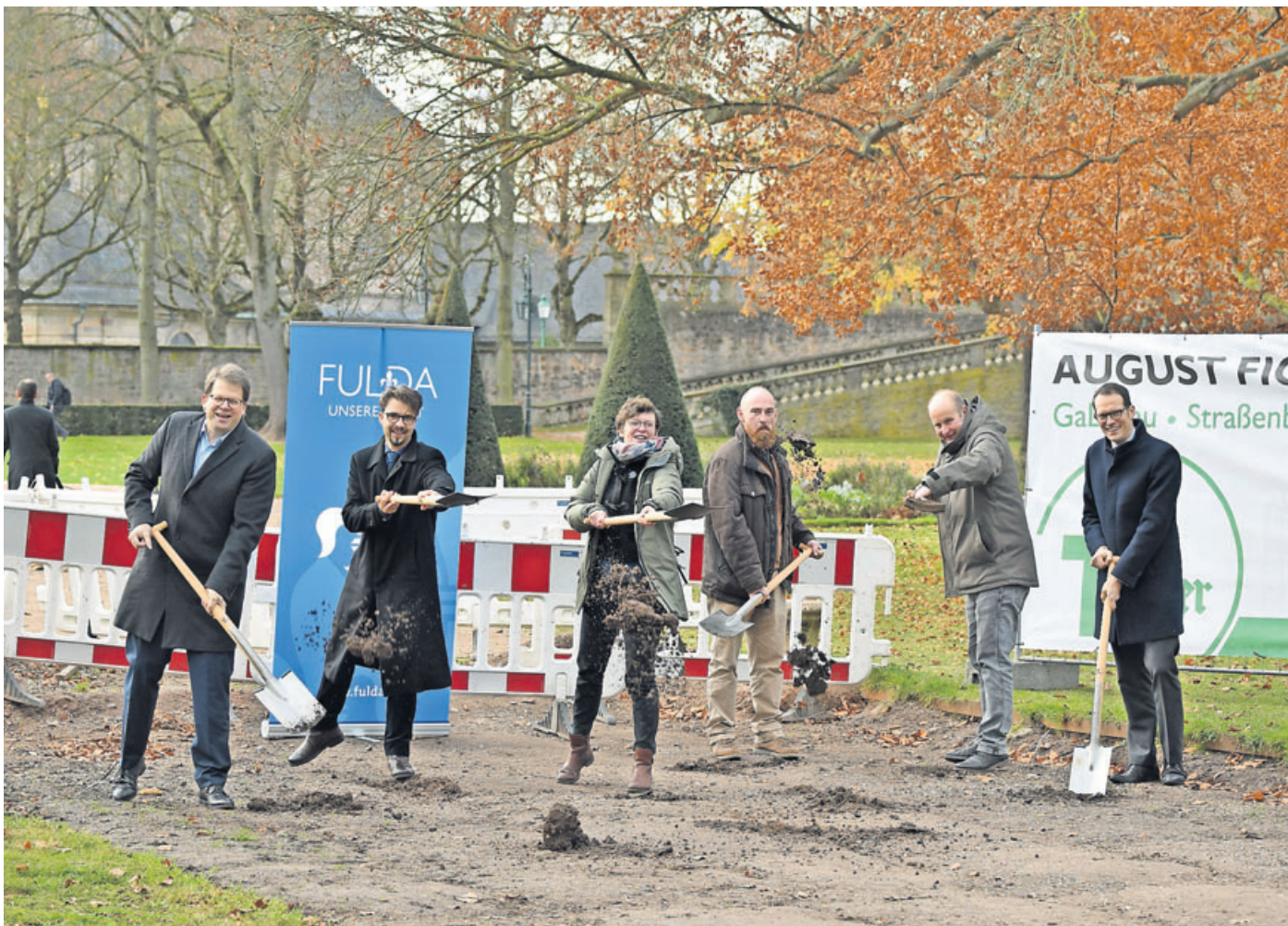
Beim dynamischen ersten Spatenstich (von links): OB Dr. Heiko Wingefeld, Ehm Eike Ehrig, Steffi Mosebach (Amt Grünflächen und Stadtservice), Harro Beyer (Bauleiter Fa. Fichter), Adrian Hehl (Untere Denkmalbehörde) und Stadtbaurat Daniel Schreiner.
