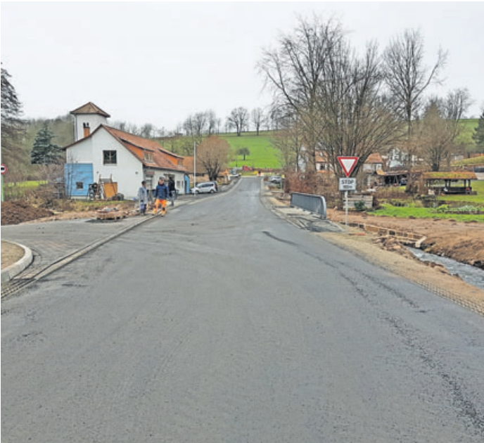
Im Zuge der Sanierung der K45 wurde die Brücke über die Lütter abgerissen und neu errichtet. Foto: Andre Jaborek
