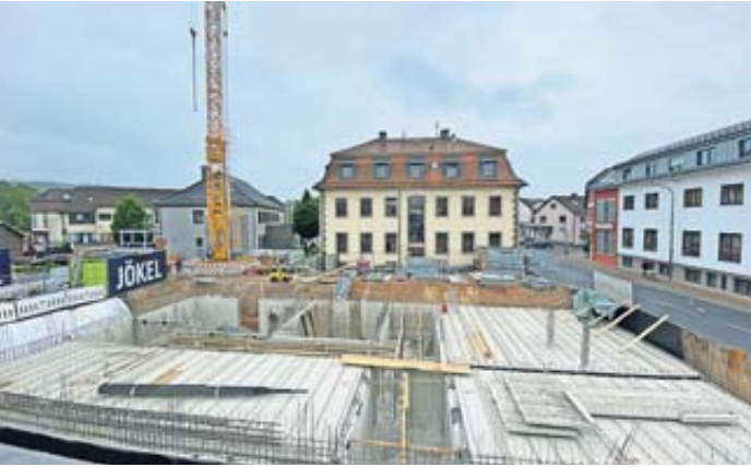
Die Bauarbeiten gehen zügig voran.
