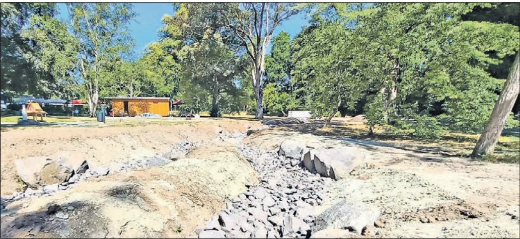
Umzäunt ist das Minigolfgelände nicht mehr, der Bachlauf mit dem Überlauf aus dem Schwanenteich soll schon bald eine Art natürliche Grenze zum Kurpark formen. Foto: js
