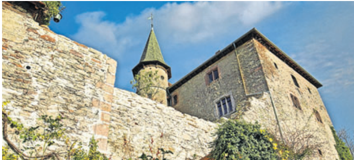
Die abgeschlossene Mauerbaustelle an der Schildmauer der Burg. Hier fanden sich Spuren einer alten, bis dahin völlig unbekannten Pforte.
