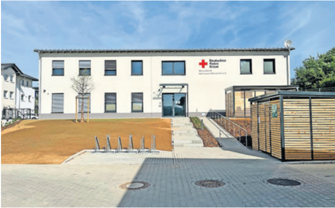
Rückseite des neuen DRK-Gebäudes.
