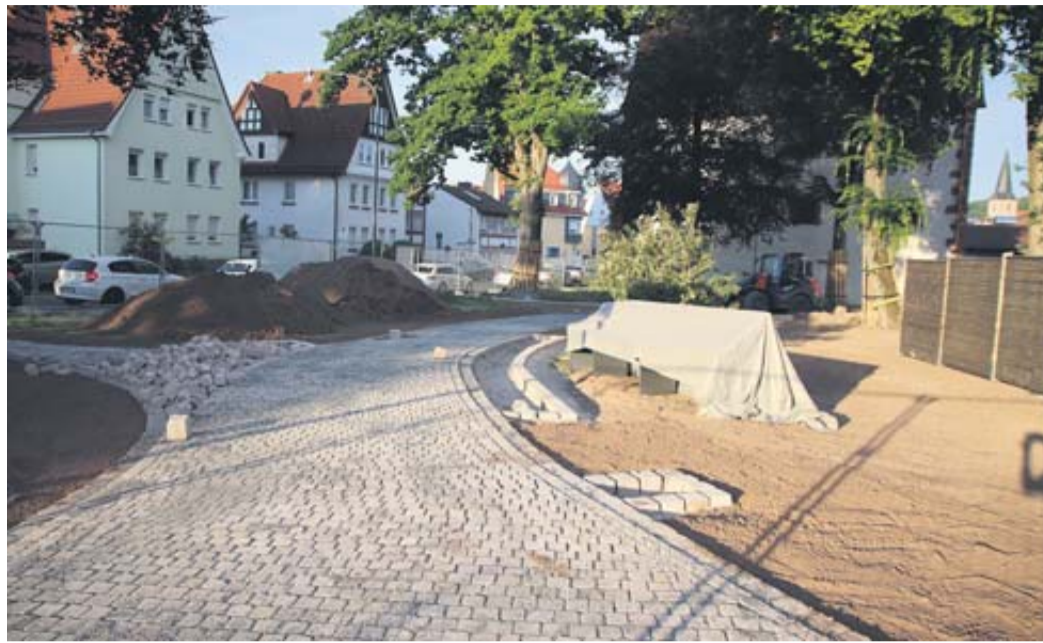
Seit wenigen Tagen werden die Wege rund um Schlösschen und Stadthalle mit „Friedewalder Quarzsandstein“ gepflastert.
