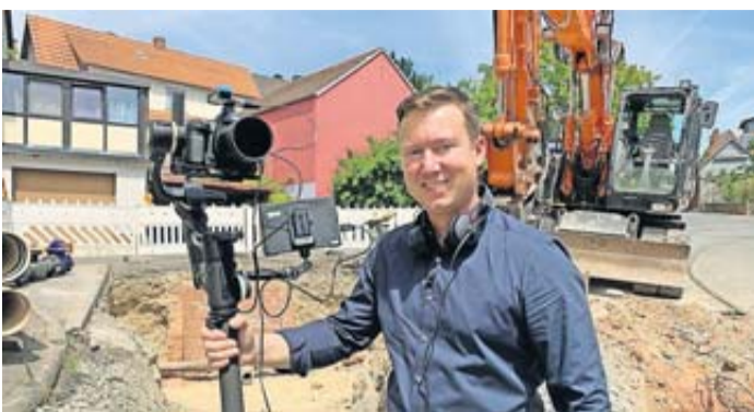
Schlüchterns Bürgermeister Matthias Möller nimmt die Zuschauer in seinem neuesten Videopodcast mit auf eine Rundreise, hier zu einer Straßensanierung in Breitenbach.
