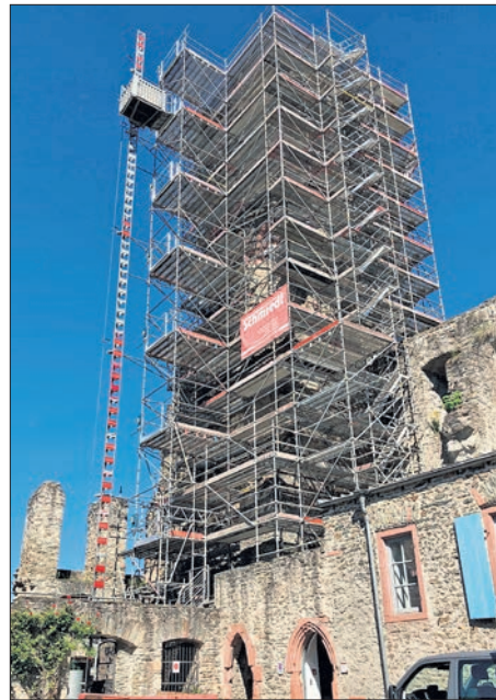
Das Gerüst am Bergfried ist endlich Vergangenheit. Die Burg öffnet wieder am 30. August, Foto: Burgmuseum Eppstein
