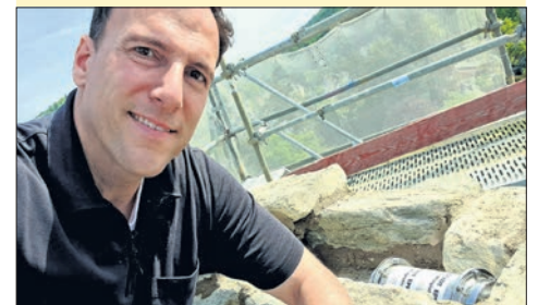
Bürgermeister Alexander Simon beim Setzen des Schlusssteins auf dem Bergfried im Rahmen der Sanierungsarbeiten. Foto: Stadt
