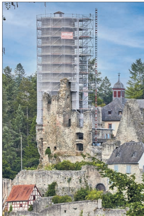
Wie sich die Ansichten gleichen: Burg mit Gerüst im September 2021. Foto: Walter Adler
