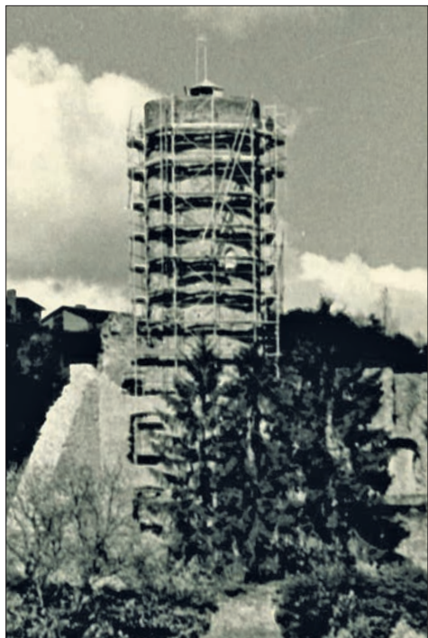
Auch bei der Sanierung 1972 war der Bergfried gerundherum eingerüstet. Foto: Stadtarchiv
