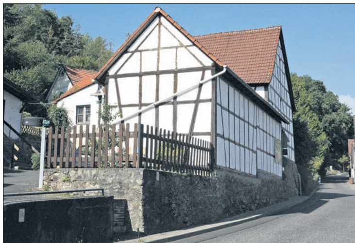
Fassade, Seiten- und Giebelwand einer alten Fachwerkscheune in der Langstraße wurden saniert. Foto: Beate Schuchard-Palmer
