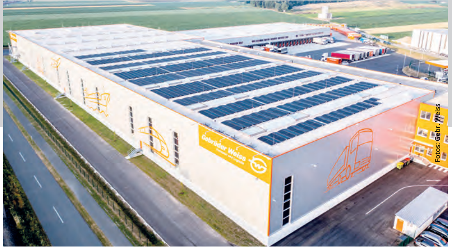
Eines der Kriterien für das Gold-Zertifikat: Die Photovoltaikanlage am Gebrüder-Weiss-Standort Graz erzeugt pro Jahr rund 460 Megawattstunden Strom – das entspricht etwa der Hälfte des Energiebedarfs des 27.000 Quadratmeter großen Logistikzentrums.
