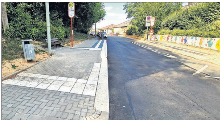
Zwei Bushaltestellen in der Freiherr-vom-Stein Straße Höhe Wiesbadener Straße: Die Haltestelle rechts wurde 2022 umgebaut, links 2018. Kinder der Comenius-Schule bemalten die Stützmauer. Foto: Stadt Eppstein
