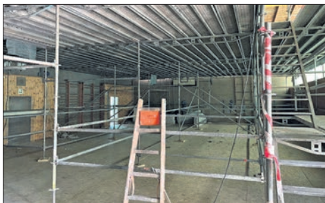
Das Dach der Turnhalle der Burg-Schule wird von außen und von innen erneuert. Foto: MTK
