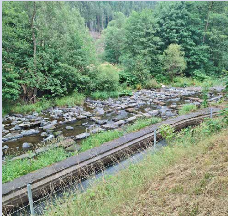
Fehlende Restwassermengen aufgrund von Anlagen der kleinen Wasserkraft an der Schwarza. Foto: Gerhard Kemmler
