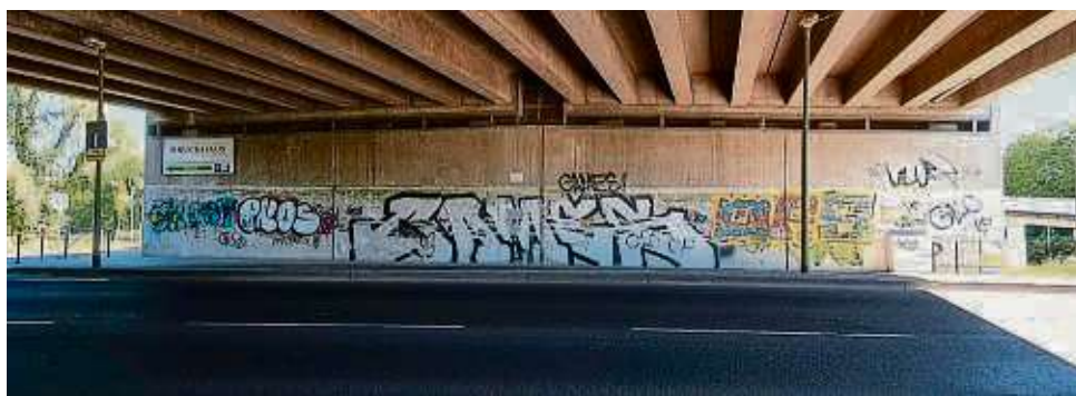
Die Wand unter der Hellentalbrücke zwischen Steinheim und Klein-Auheim sieht derzeit wenig einladend aus. Ein Graffiti mit Bezug zu den Stadtteilen soll das bald ändern.
