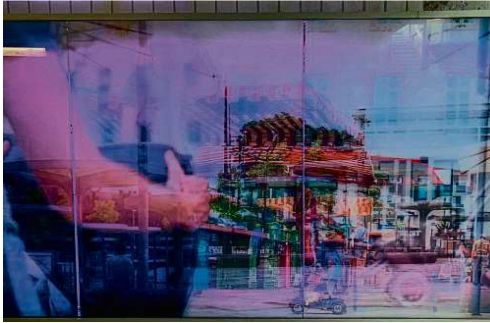
LED-beleuchtete Glaspaneele: Eine erste Musterfläche wurde bereits angebracht, eine Bemusterung der Motive wird Ende des Monats erfolgen.
