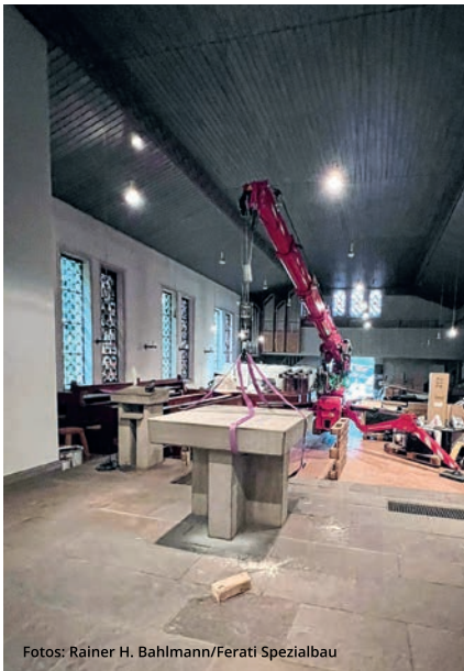
Fundamental: Altarplatte und die Sockel wurden auf ein neu gegossenes Fundament im Freien platziert.
