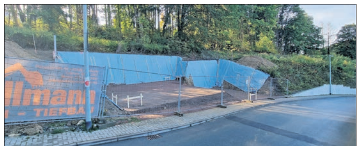
Erdarbeiten auf einem der neu parzellierten Grundstücke am Eppenhainer Weg im Oktober 2022.
