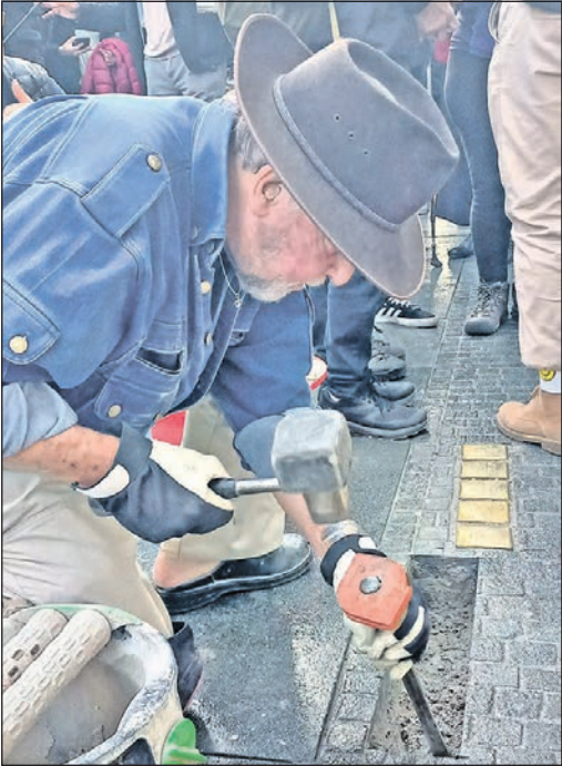
Unbeeindruckt von Reden, Fotografen und Kameraleuten des Fernsehens macht Gunter Demnig sein Ding. In die „Baulücke“ neben seinen im vergangenen Jahr verlegten Steinen kommen die fünf neuen Stolpersteine.
