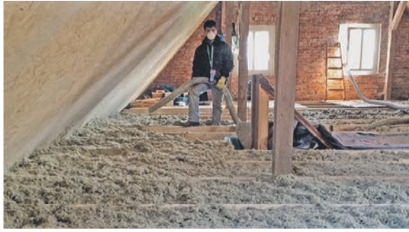
Eine Einblasdämmung mit Steinwolle eignet sich hervorragend für den Einsatz im Dachboden.
