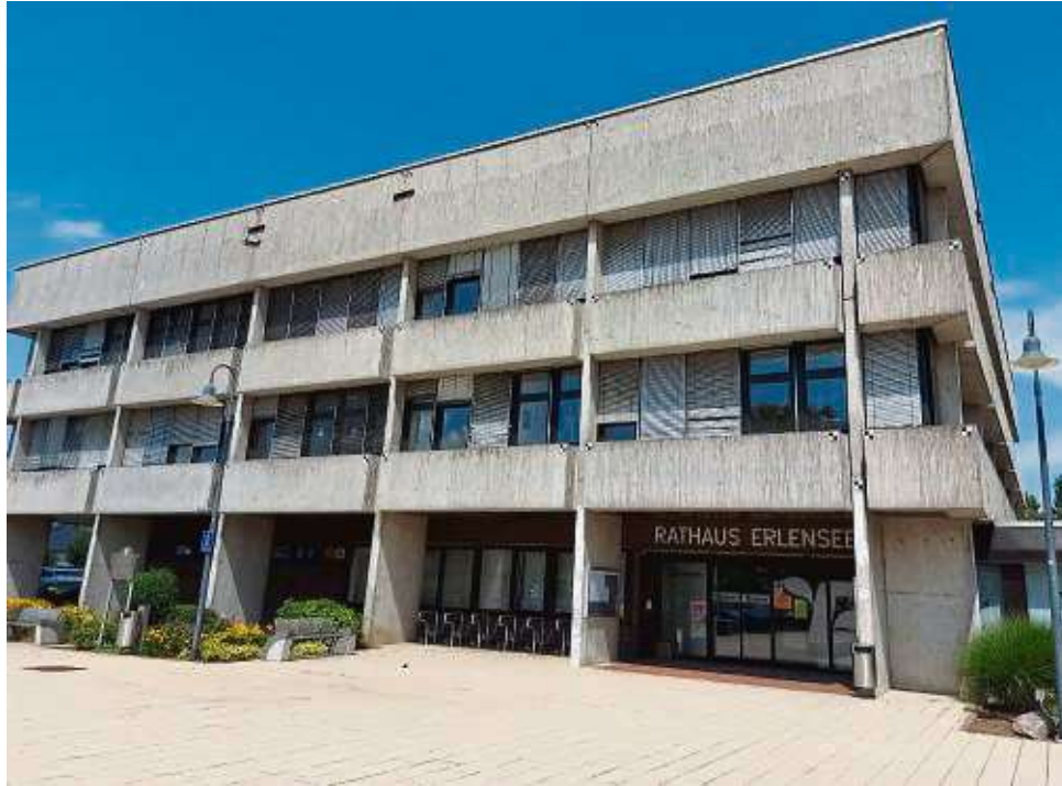
Es geht voran: Ende 2021 wurde die Kernsaniierung des Rathauses beschlossen. Nun arbeitet laut Bürgermeister Stefan Erb ein Architekturbüro sowie ein Projektsteuerungsbüro am Bauantrag.
