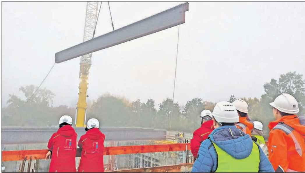
Spannung im Morgennebel: Von der „Kommandobrücke“ auf der Baustelle beobachten Bauleiter, Statiker und Enzo Spadano vom städtischen Gebäudemanagement (mit gelber Weste) die Himmelfahrt des 28 Tonnen schweren Stahlverbundträgers. Foto: js
