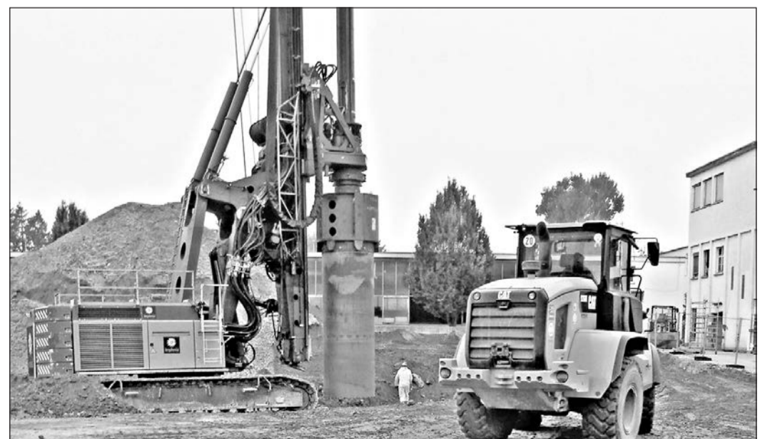
Das Großlochbohrgerät im Einsatz auf dem Areal.
