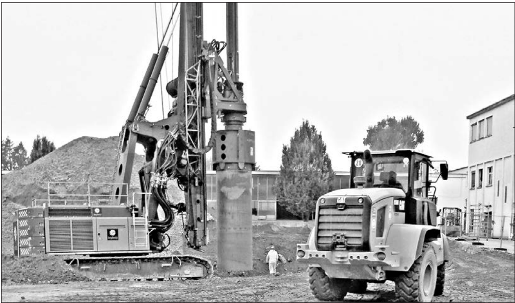
Das Großlochbohrgerät im Einsatz auf dem Areal.
