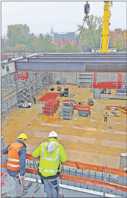
Blick in die spätere Wettkampfhalle mit Tribüne. Wenn alle acht Träger perfekt sitzen, kommt eine Betondecke drüber und eine zweite Sporthalle drauf. Foto: js
