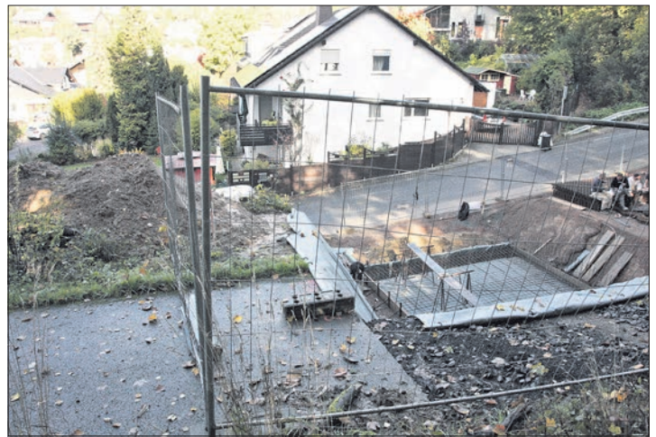
Die Zufahrt zu Opls Grundstück beginnt jetzt im Nichts. Dort wird gerade eine Baugrube für ein neues Haus ausgehoben.
