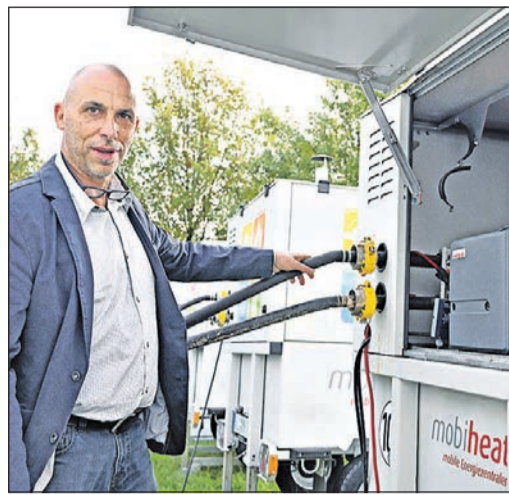
Lutz Trepte, technischer Leiter der Hochtaunus-Kliniken, erläutert an einem Aggregat die Funktionsweise. Foto: Jk
