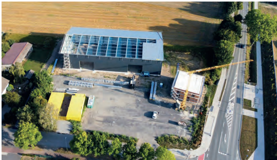
War früher mal ein bäuerlich genutztes Anwesen: Neben einer großen Halle entsteht auch ein kleineres Bürogebäude am neuen Standort im Soester Norden.
