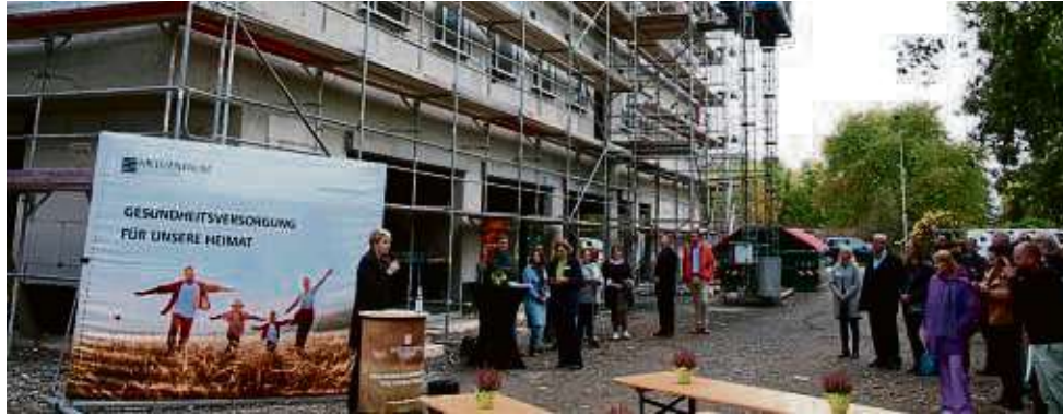
Die Gebäudehülle ist geschlossen, das Dach ist dicht: Sieben Monate nach dem Baustart konnte das Richtfest des neuen Ärztehauses gefeiert werden.
