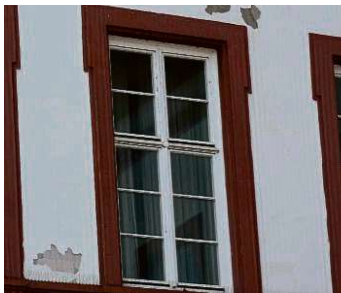
Im Rahmen der Sanierungsarbeiten werden unter anderem Putzschäden an der Schlossfassade beseitigt.
