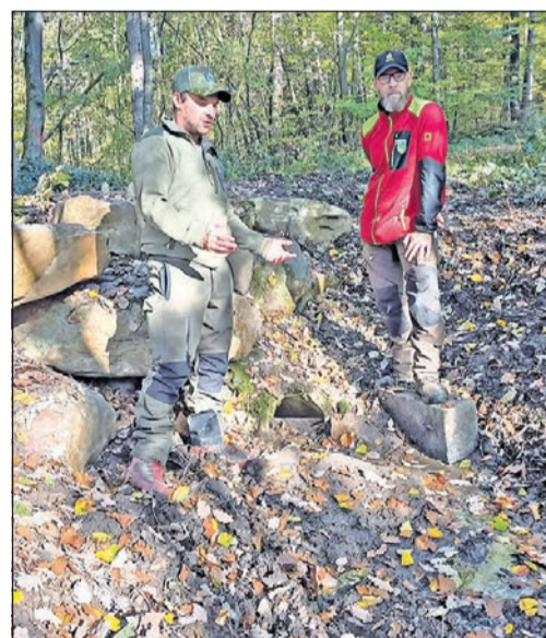
Förster Luis Kriszeleit und Bergwald-Projektleiter Henning Aulich (v. l.) überprüfen den freigelegten und neugestalteten Zulauf zum oberen Weiher, eine Maßnahme mit Handarbeit auf schlammigen Untergrund. Foto: js
