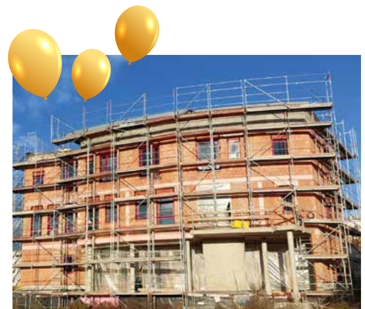
Um- und Erweiterungsbau Kinderhospiz Wiesbaden, November 2022
