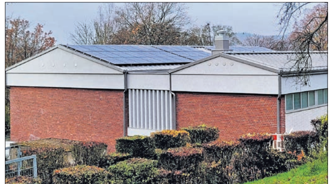
Das Dach der Turnhalle der Burg-Schule wurde erneuert und erhielt eine Photovoltaik-Anlage. Foto: MTK-Pressestelle
