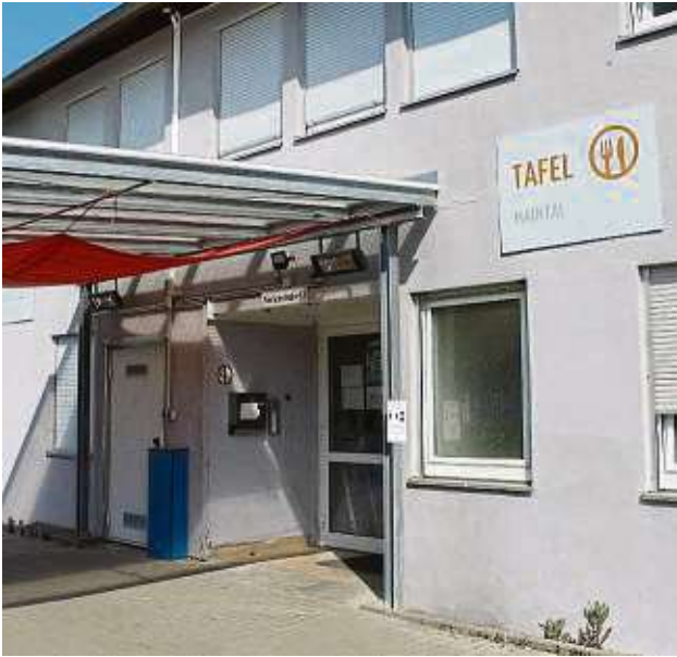
Die Bürgerhilfe befindet sich in der Neckarstraße 13 in Dörnigheim. Auch die Tafel, Herzstück des Vereins, ist hier untergebracht.
