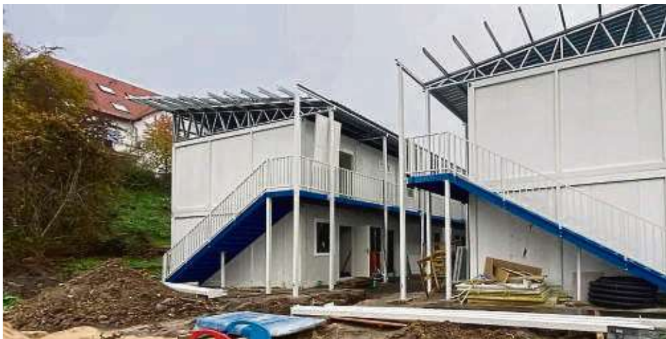
Die Stadt Bruchköbel baut derzeit eine Wohnanlage in Modulbauweise an der Friedberger Landstraße. Sie soll noch in diesem Jahr fertiggestellt werden und Platz für etwa 70 Menschen bieten. Auch auf dem Fliegerhorst soll nun eine ähnliche Gemeinschaftsunterkunft für Flüchtlinge aus zweigeschossigen Containern entstehen.
