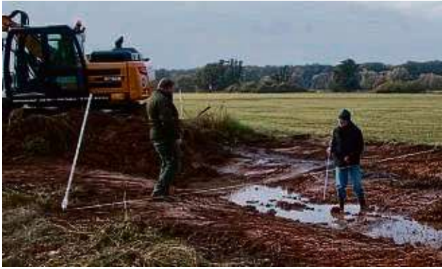
In der Langenselbolder Flos hat die Gesellschaft für Naturschutz und Auenentwicklung in den vergangenen Monaten ein neues Feuchtgebiet geschaffen. FOTO: PM
