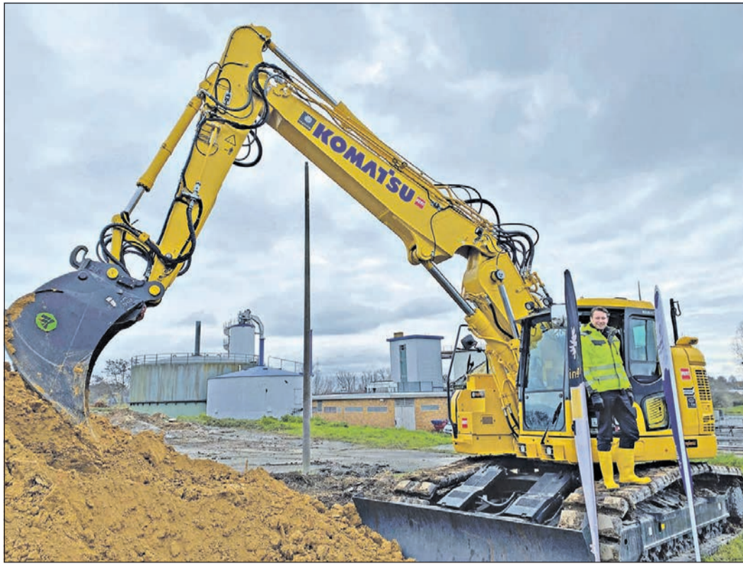
Statt des klassischen Spatenstichs hat Oberbürgermeister Alexander Hetjes die Baggerschaufel angesetzt. Foto: Stadt Bad Homburg
