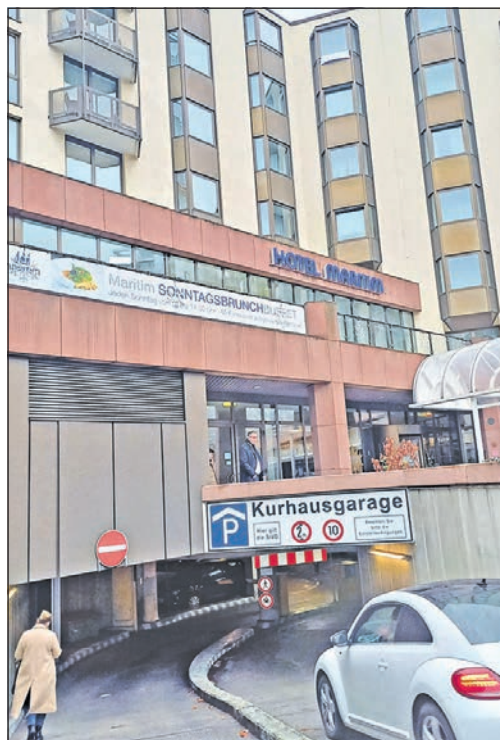
Wie sich das „Maritim“ – hier der Blick auf Haupteingang und Einfahrt in die Kurhausgarage – ins Bild integrieren wird, dürfte viele spannende Fragen aufwerfen. Foto: js
