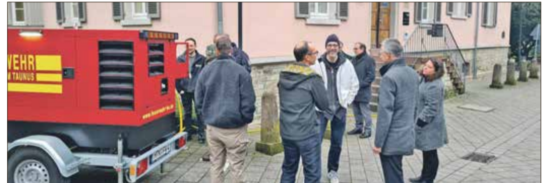
Der dieselbetriebene mobile Generator soll im Ernstfall für die Stromversorgung im Paulinenschlößchen sorgen.
