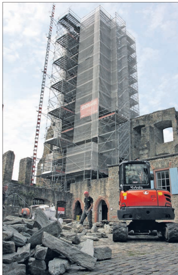
Mai: Der Bergfried erhält eine neue Mauerkrone. Erst nach den Burgfestspielen wird das Gerüst abgebaut.
