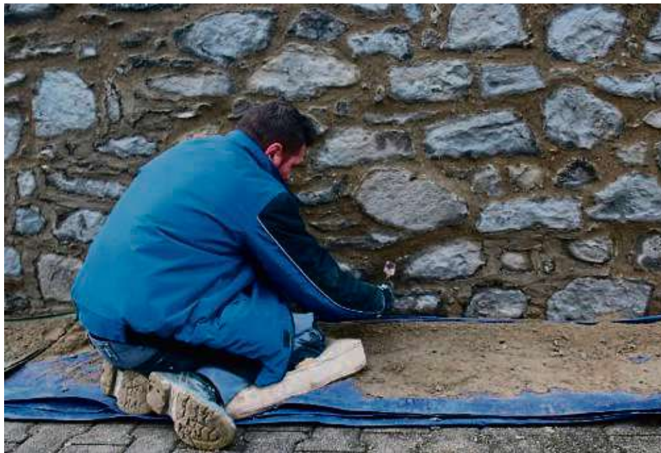
Nachdem die alte Mörtelschicht abgetragen und das Mauerwerk mit Granulat gereinigt wurde, wird mit Mörtel neu verfugt. Sämtliche Arbeiten erfolgen dabei in Handarbeit und Stein für Stein.
