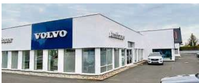
Nach einem Jahr Umbaumaßnahmen erstrahlt das Autohaus Amthauer jetzt in neuem Glanz. FOTOS: PM
