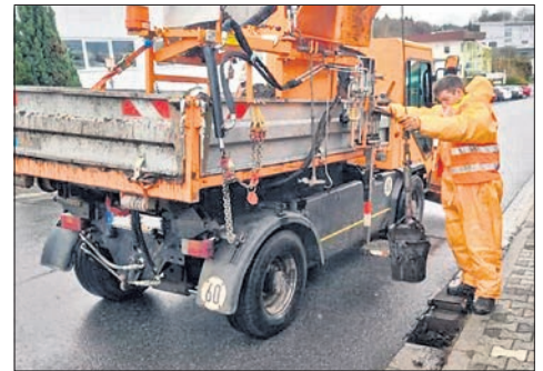
Mit technischer Unterstützung reinigen die Mitarbeiter des Bauhofs die Sinkkästen im Stadtgebiet. Foto: Stadt Eppstein
