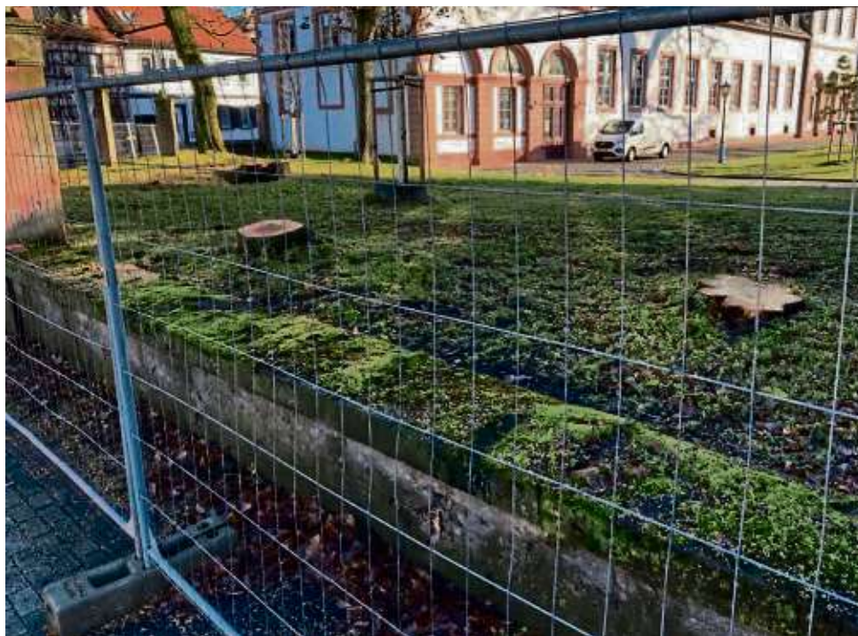
Als Vorarbeiten für die Sanierung der Sandsteinbrüstung des Zauns des Parks von Schloss Philippsruhe wurden dieser Tage sechs Bäume gefällt.
