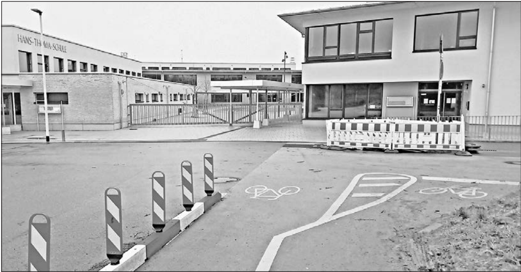
Bei Ankunft an der Hans-Thoma-Schule von Norden aus ist der Radweg bisher zu Ende, der weiße Querstrich auf der Fahrbahn (rechts) macht das klar. Ab hier wird der Radweg nun weitergeführt über das Teilstück Mainstraße bis zur Dornbachstraße. Foto: js
