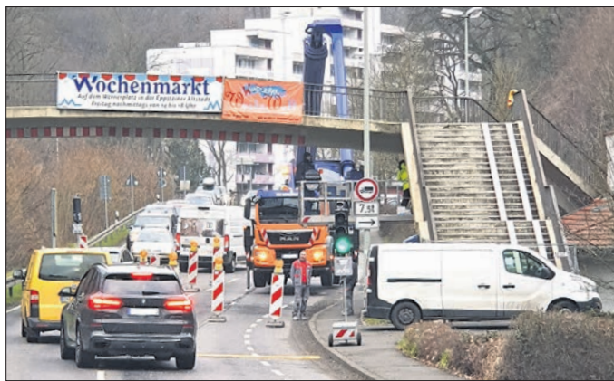
Die Unterkonstruktion der Bahnbrücke wurde vorige Woche untersucht. Die Brücke bleibt weiterhin gesperrt. Foto: privat
