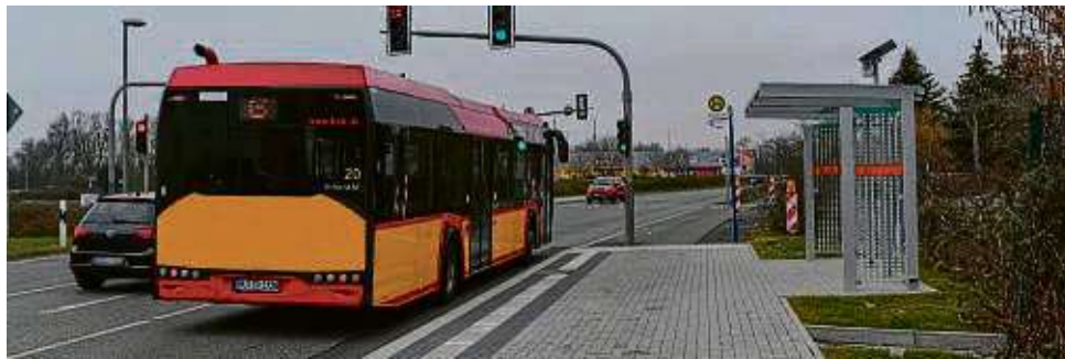
Kürzlich sind acht neue, barrierefrei ausgebaute Bushaltestellen im Stadtgebiet entstanden. In Großauheim gibt es nun beispielsweise zwei komplett neue Bushaltestellen am Knotenpunkt Depotstraße Philipp-Heck-Straße.
