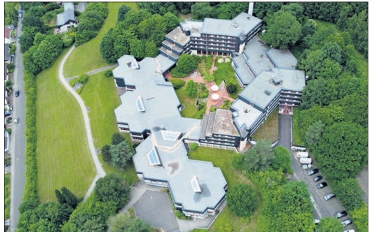
Die Luftaufnahme der GWH zeigt die ungewöhnliche Architektur des Akademiegebäudes, das sich in den Hang hinein zu schmiegen scheint.
