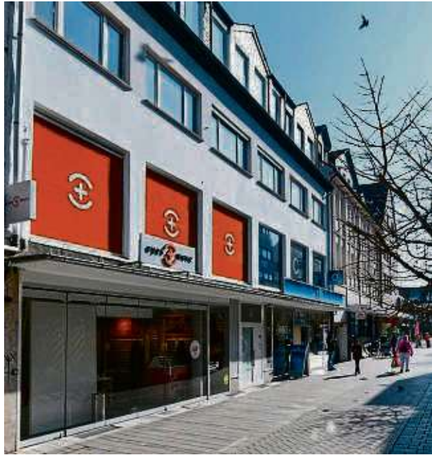
Mit Hilfe der Vorkaufssatzung erwirbt die Stadt Hanau zwei Wohn- und Geschäftshäuser in der Hanauer Fußgängerzone.
