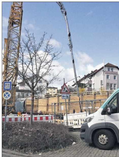
Zurzeit wird die Bodenplatte für die Wohnanlage gegossen. Foto: Beate Schuchard-Palmer
