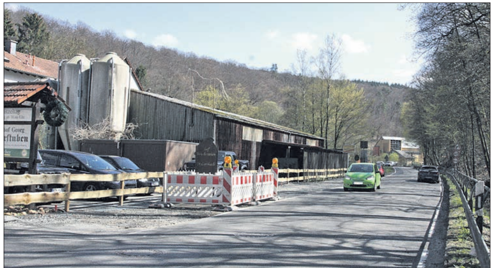
Die L3011 am Lorsbacher Ortsausgang Richtung Hofheim. Dort muss die Straße samt Stützmauer der Klärwerkskurve erneuert werden, nun voraussichtlich in mehreren Bauabschnitten. Foto: jp
