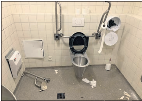
Beschädigungen in der Toilette am Bahnhof. Foto: Stadt Eppstein
