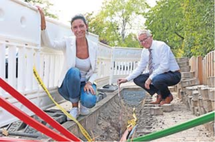
Breitband-Geschäftsführerin Simone Roth und Wirtschaftsdezernent Winfried Ottmann beim Besuch einer Baustelle, an der aktuell Glasfaserstränge verlegt werden. Foto: Bensing & Reith
