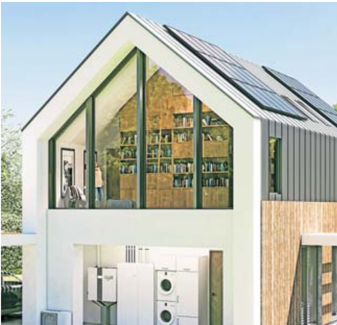
Grundvoraussetzungen für solare E-Mobilität sind eine ausreichend hohe Photovoltaik-Erzeugungsleistung und ein für das nächtliche Laden geeignetes Speichersystem. Foto: djd/E3/DC
